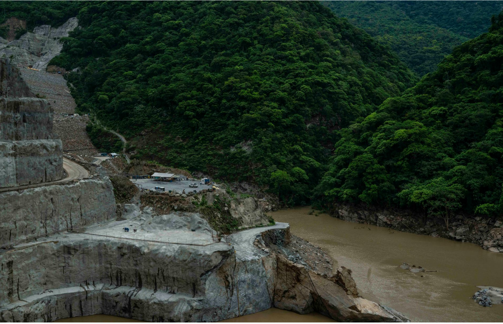
Imagen de la represa de Hidroituango. Federico Ríos.
